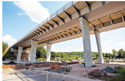
Die fertige Brücke: Bauzeit von April 2012 bis August 2018, Kosten rund 34 Millionen
