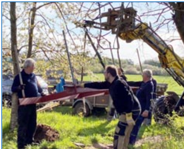
Die Unterkonstruktion wird mittels Stapler eingefahren. Zu sehen: Walter Reiß, Holger Bier, Christian Rust, Hans Werner Günther
