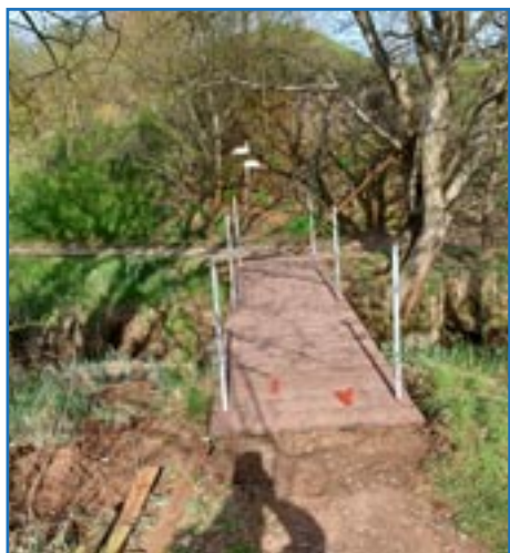
Die neue Brücke ist fast fertig
